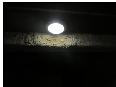
Photo N° 939 AMIANTE CIMENT -- LOCAL VO -1 Gaines & coffres horizontaux Ventilation haute (Fibres-ciment)
